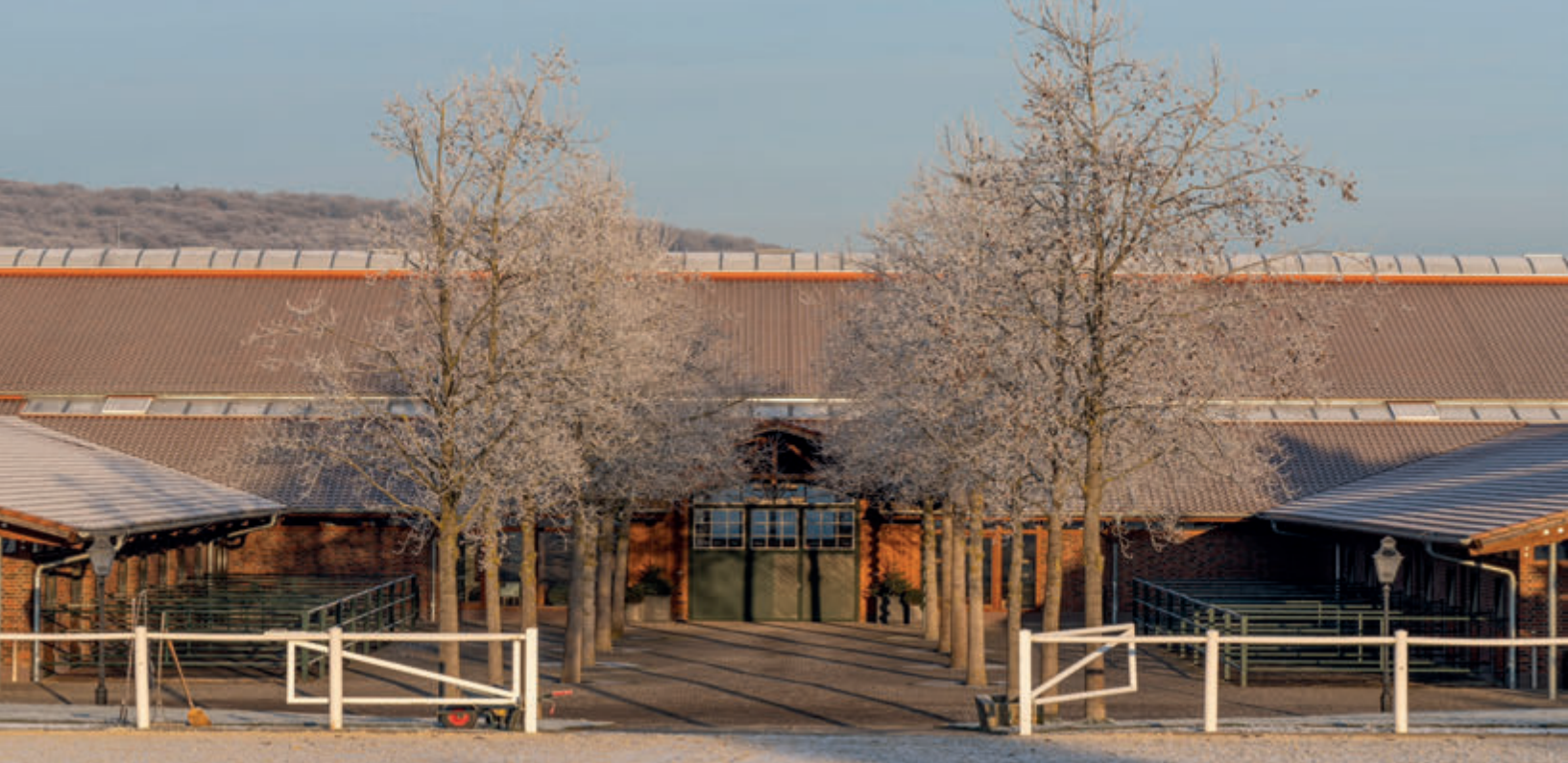
Einladend wirkt der Eingang zur Anlage..
