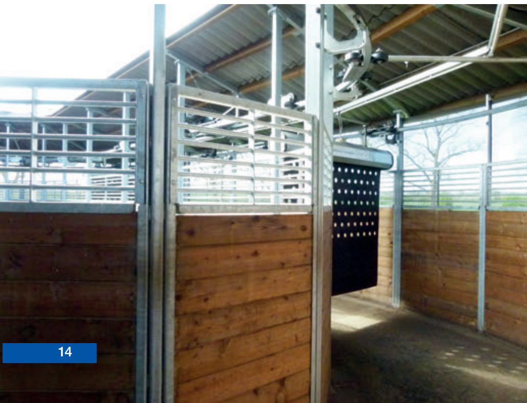
In der ovalen Führanlage, laufen die Pferde nicht nur im Kreis, sondern haben auch gerade Strecken.
